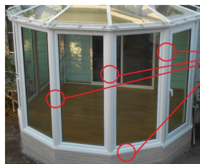
軸組(柱) (下枠): アルミ フロント材
