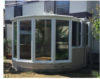
タイプⅢ 施工例
